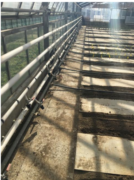
Figure 15 : photo exemple adductions fluides compartiments pleine terre.
